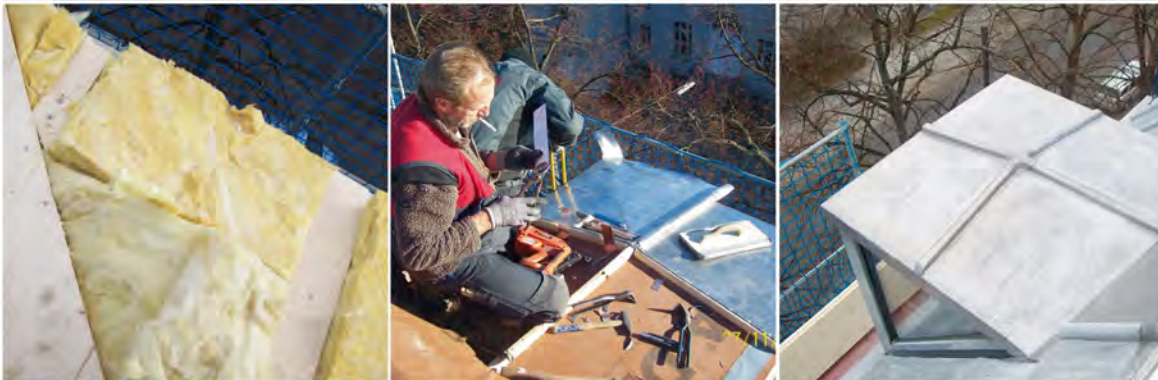
Nach Erhöhung des Gefälles der Gaubendächer setzten die Spengler Rundholzleisten im Nahtbereich ein
