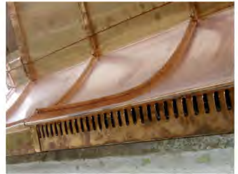
Frische Luft: Trauf- und Abschlussdetail mit ausgeklügelter Lüftungsöffnung
