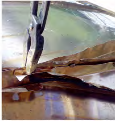
Spenglerknoten: Nicht nur Seeleute verstehen etwas von Knotenpunkten. Die stehende Falzeinführung am Gratpunkt gehört zu den Spenglertechniken mit Tiefgang
