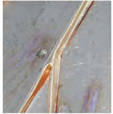
Spenglerknoten: Nicht nur Seeleute verstehen etwas von Knotenpunkten. Die stehende Falzeinführung am Gratpunkt gehört zu den Spenglertechniken mit Tiefgang
