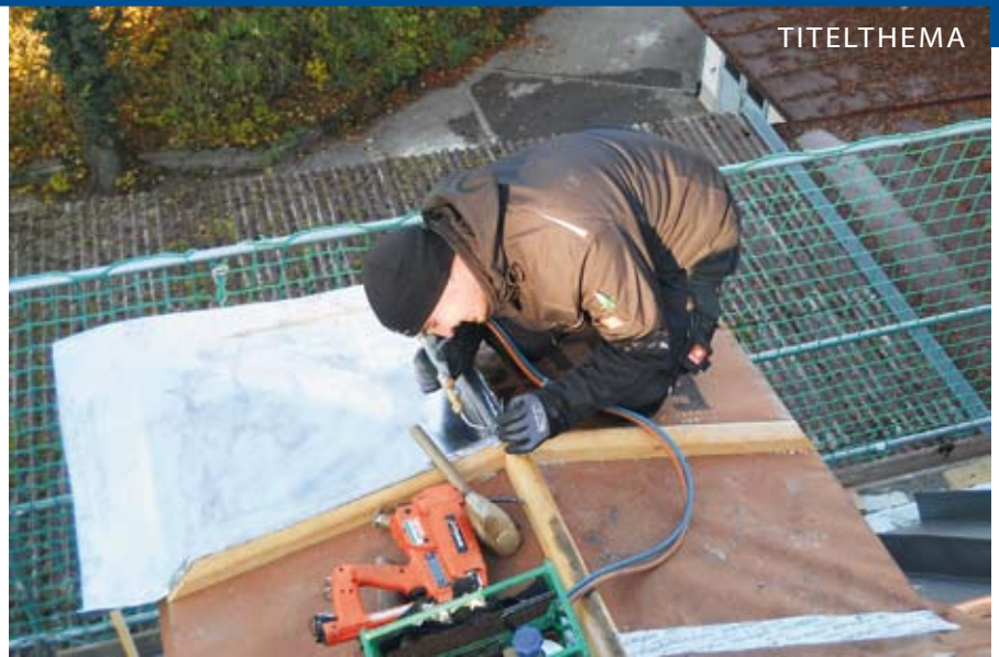
Die Gaubendächer bekamen eine neue Dachkonstruktion, um ein erhöhtes Gefälle zu ermöglichen. Die anschließende Bleieindeckung wurde als Holzwulst (Falz mit Holzkern) ausgeführt.
