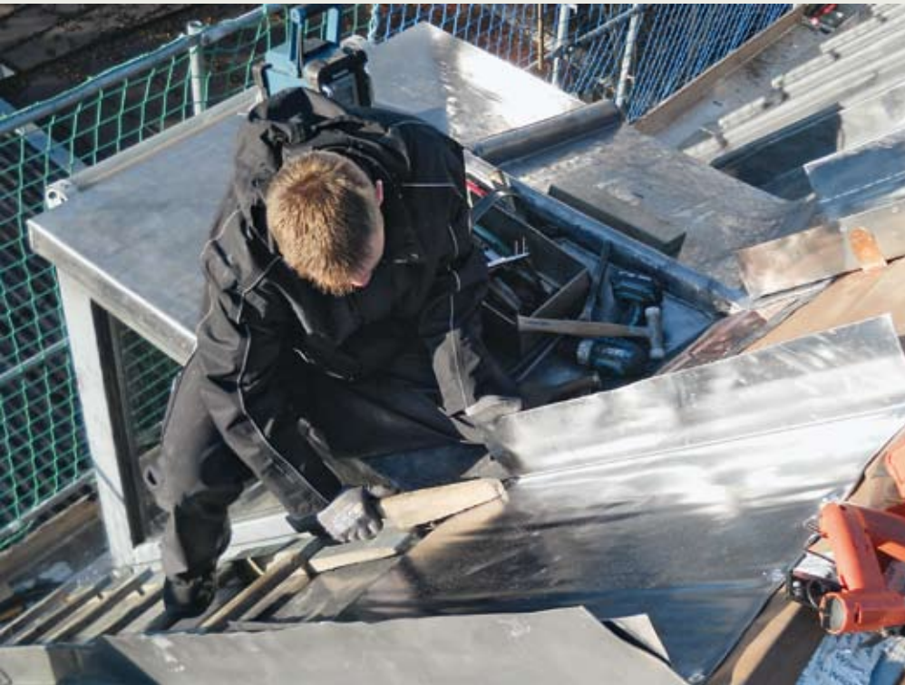
Auch auf dem Steildach kamen vorkonfektionierte Bleibleche zum Einsatz.
