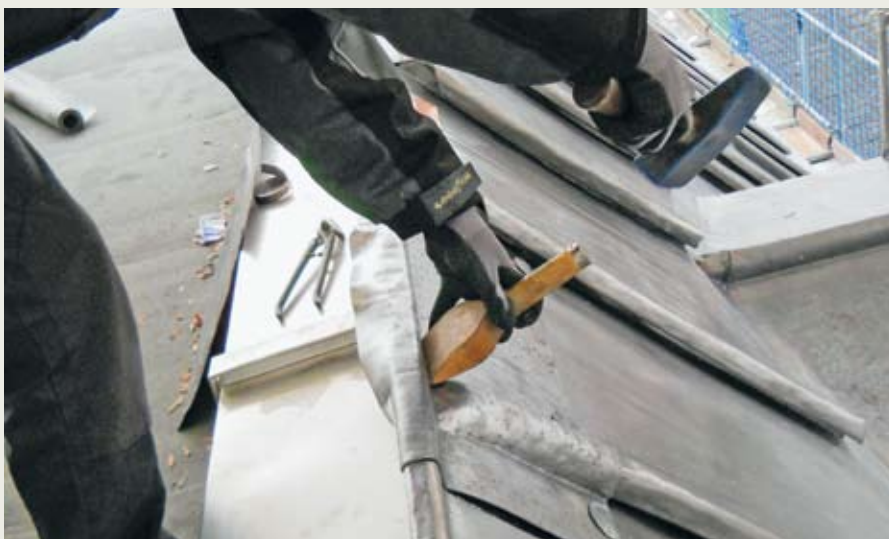
Als Übergang vom Steildach zum Flachdach wurden speziell gekantete Edelstahlbleche mit 4 cm Aufkantung am Firstscheitelpunkt montiert. Die Walzblei-Überhänge wurden dann von der Steildachseite aus um die Bleche herum getrieben.
